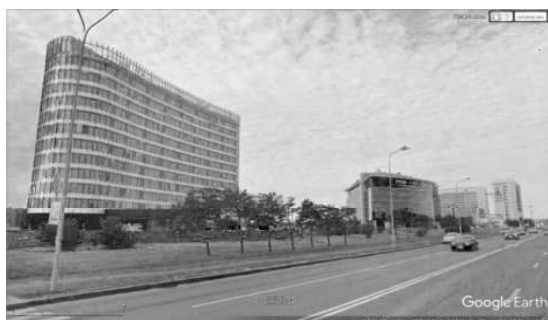
Рис. 63. «Аэропорт-Сити», полифункциональный деловой комплекс, г. Санкт-Петербург
