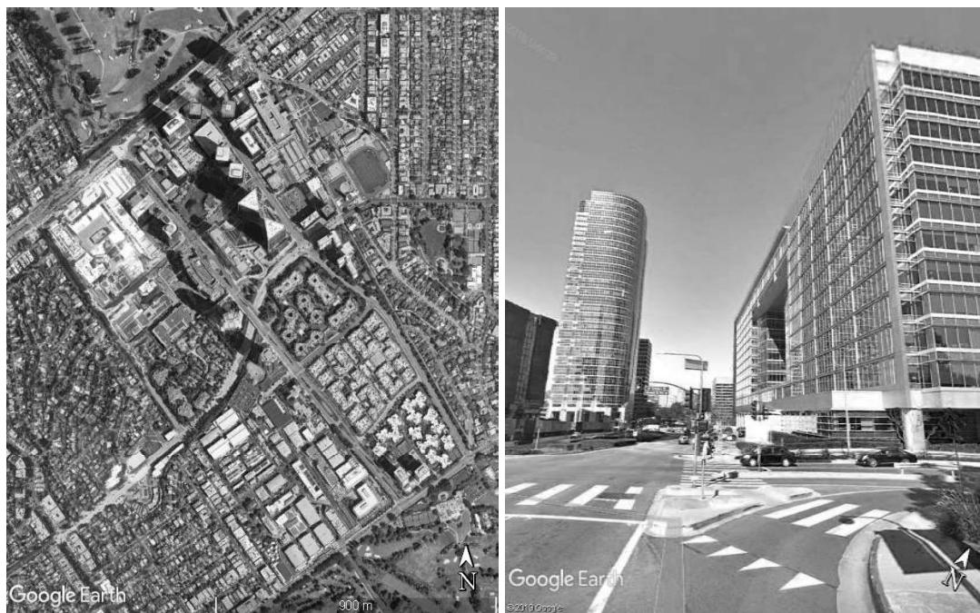
Рис. 30. Вторичный элемент системы центра агломерации г. Лос-Анджелеса: район Сенчери Сити (Century City). Аэрофото-съемка и наземный вид
