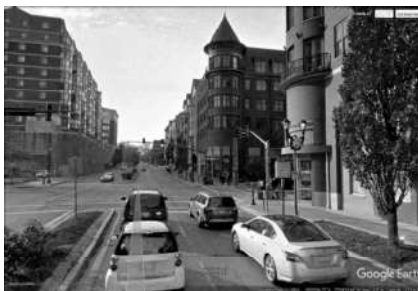
Рис. 96. Центр г. Роквилл, пригорода агломерации г. Вашингтона, США – крупный поли- функциональный городской комплекс (аэрофотосъёмка и наземный вид)
