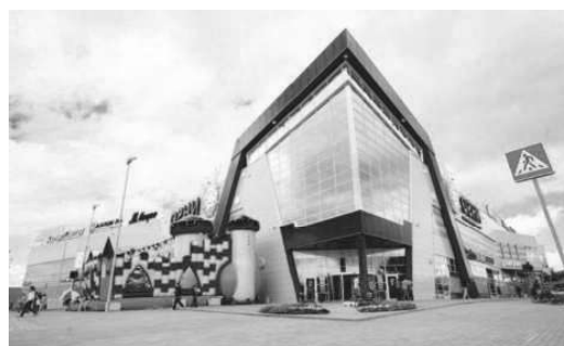
Рис. 66. Торговый и деловой центр «Огни», г. Барнаул [291]
